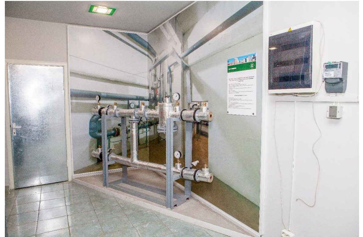
Внутри дома оборудован подвал.
